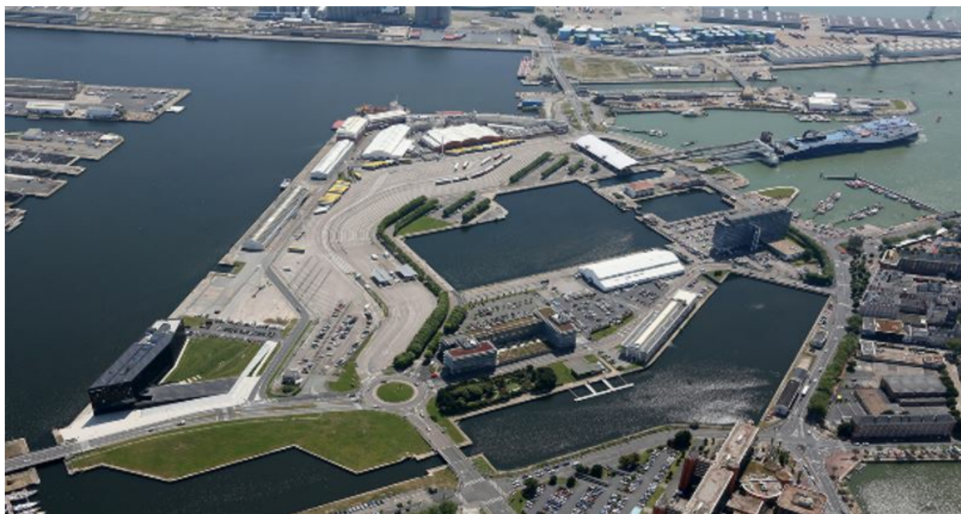
Terminal de Grand Bretagne au Havre
